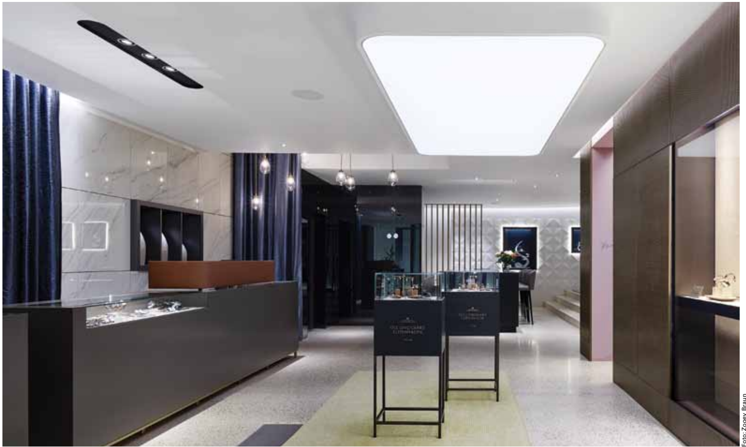
Die eingebauten Strahler über der Theke wurden auch als Pendelleuchte ausgeführt. Daneben Lichtdecke und Voutenbeleuchtung
