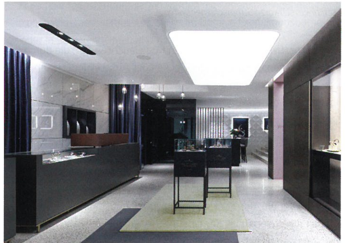
Abb.: Im Bereich Schmuck und Uhren übernehmen Lichtdeckenelemente die Allgemeinbeleuchtung. Die Beraterplätze mit integrierten Schaukästen aus Glas werden durch Einbaustrahler in der Decke direkt beleuchtet.
