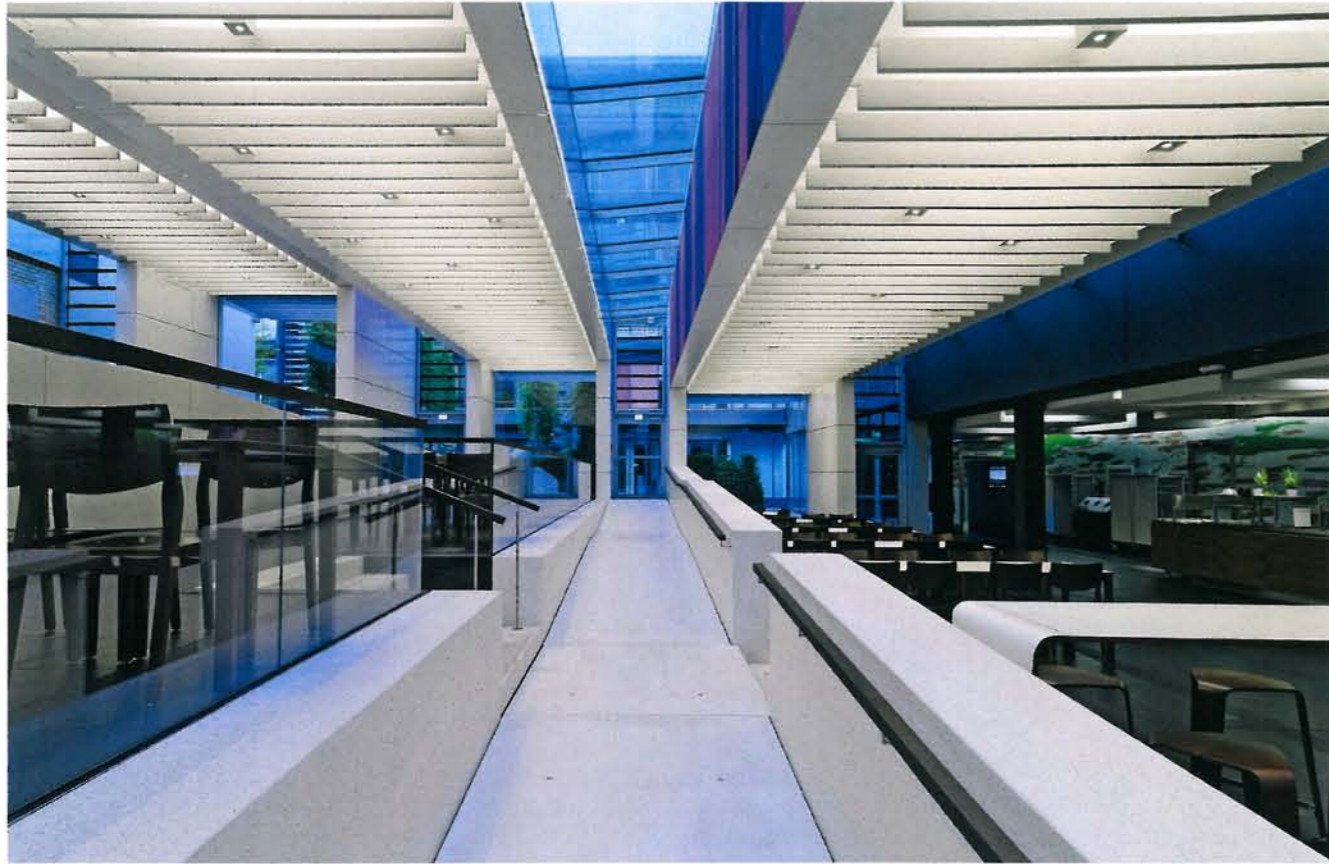
In enger Abstimmung mit den Architekten wurden indirekt strahlende LED-Lamellen entwickelt, die innerhalb der Deckenfelder eine weiche, absolut gleichmäßige Grundbeleuchtung erzeugen.
